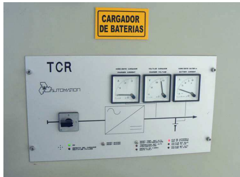
FIGURA 1.36.- RECTIFICADOR/CARGADOR
