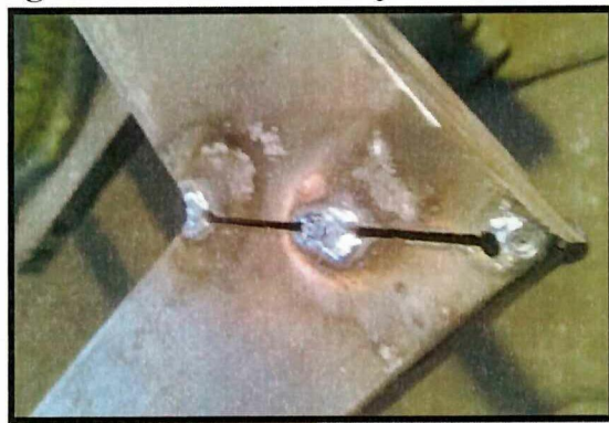
Figura N° 3. 11. Ensamblaje de la estructura.
