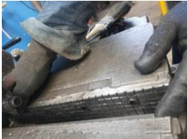
Figura 13. Reparación de piezas metálicas en la cepilladora
