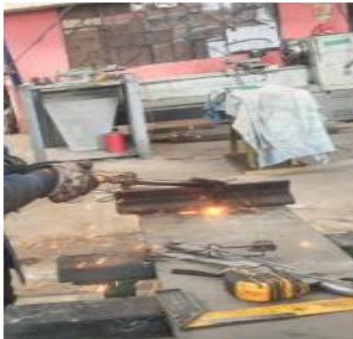
Figura 15. Unión de piezas metálicas por suelda
