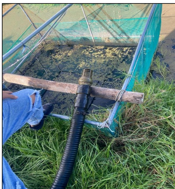
ANEXO E2: VERIFICACIÓN DE VÁLVULA DE PIE.
