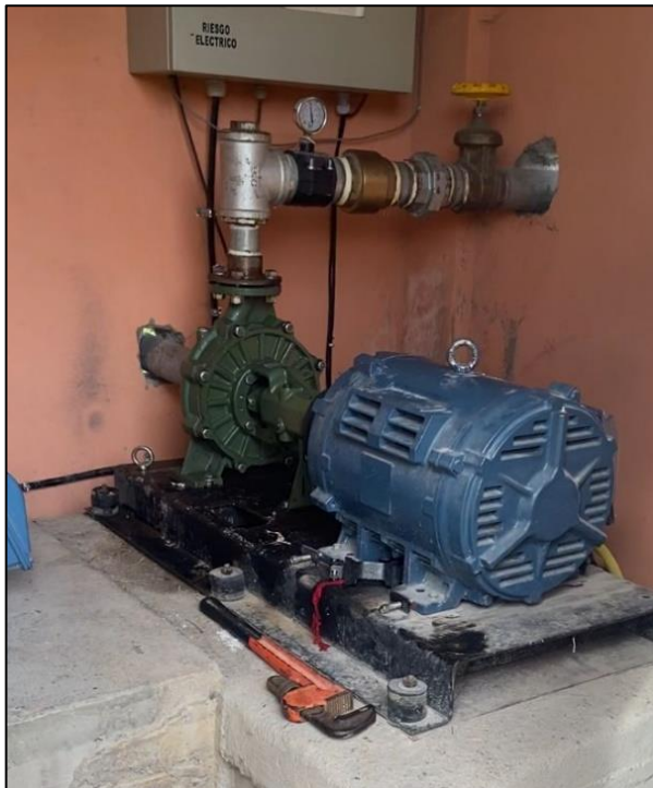
ANEXO H8: PUESTA A SERVICIO DE LA BOMBA CENTRÍFUGA.
