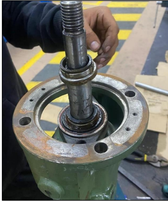
ANEXO F5: DESMONTAJE DEL SELLO MECÁNICO.
