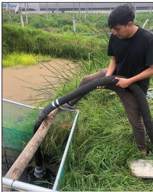
ANEXO H1: CAMBIO DE VÁLVULA DE PIE.
