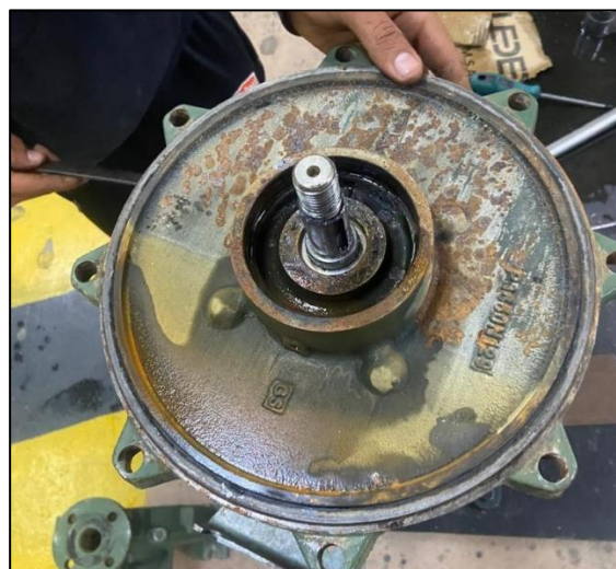
ANEXO F2: DESMONTAJE DE ANILLOS DE DESGASTE.
