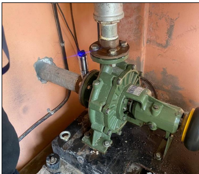
ANEXO I2: MEDICIÓN DE VIBRACIONES EN LA BOMBA CENTRÍFUGA.
