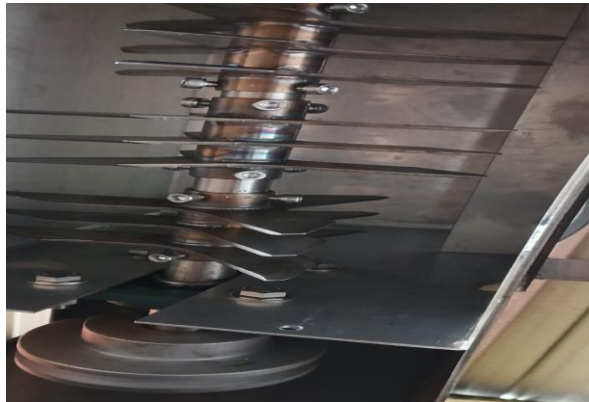
Figura 9. Vista interna del árbol de cuchillas montada en la estructura.
