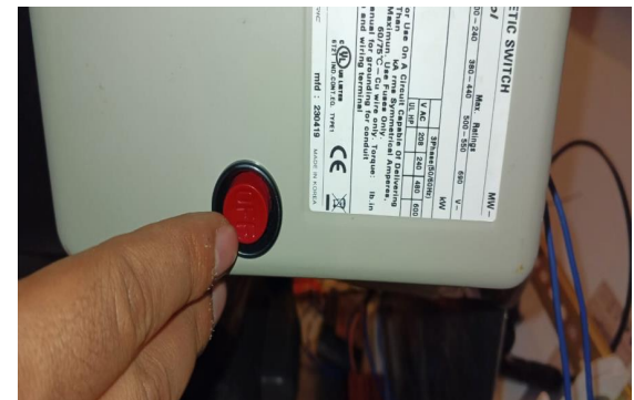
Figura.12 Botón de apagado del arrancador directo.
