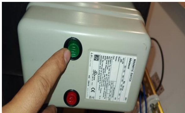
Figura 11. Botón de encendido del arrancador director
