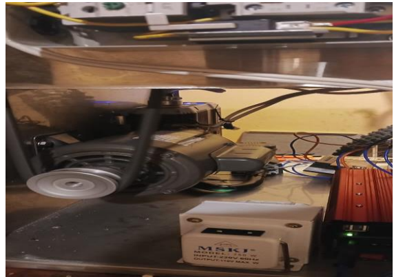
Figura 10. Vista interna de los elementos montados en la estructura.
