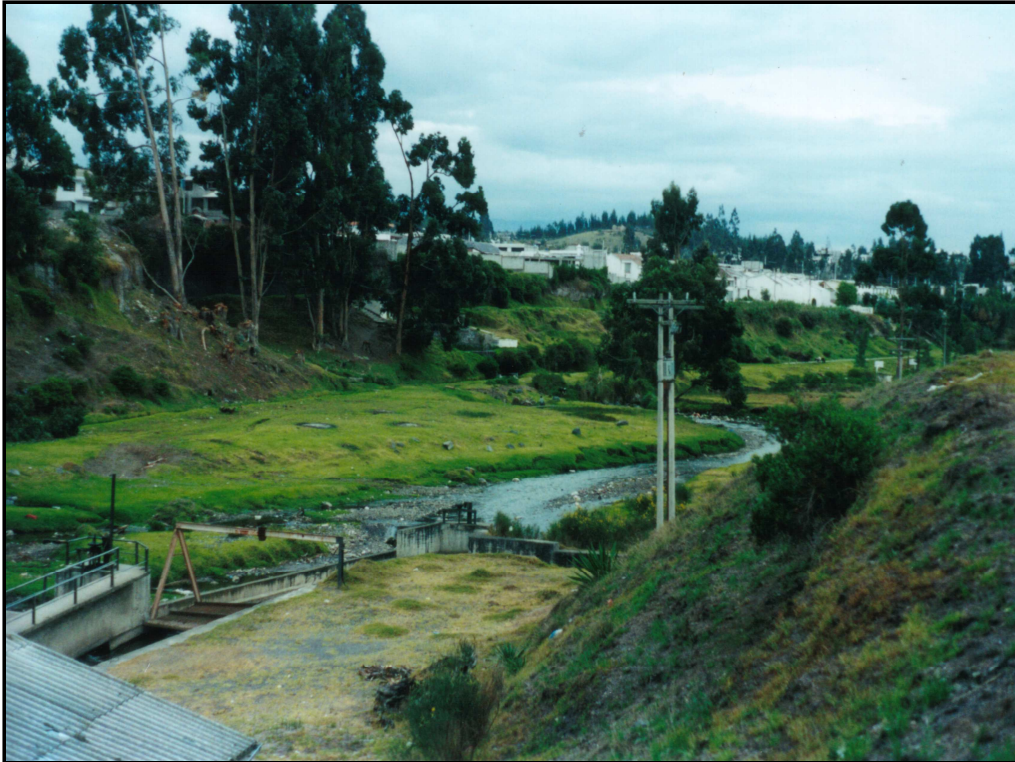
Fotografía 9: Toma de Agua. Latacunga
