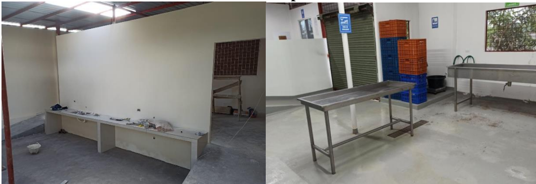
Figura 42. Implementación de cambios de infraestructura interna.
