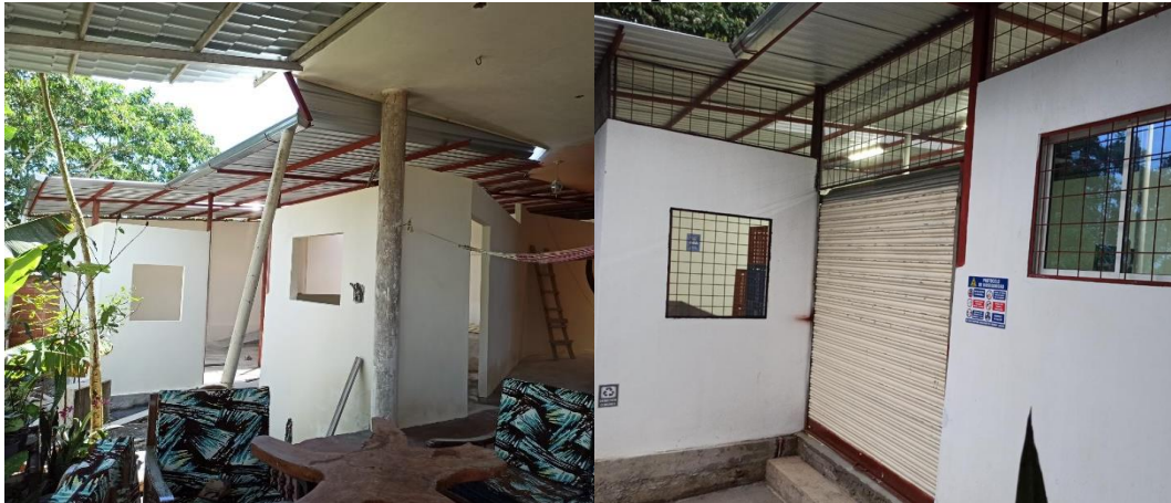
Figura 41. Implementación de cambios de infraestructura externa.
