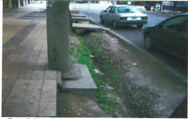
Foto 3.3. a. Acequia antigua –piedra consolidada con tierra- destapada
