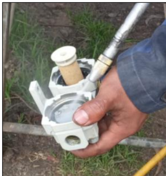
Figura P. 8 Limpieza de bases.
