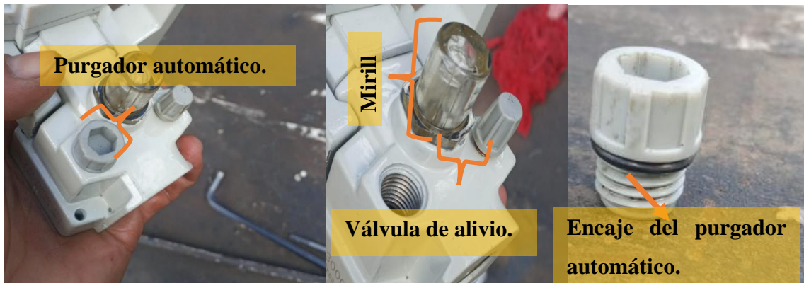
Figura P. 15 Purgador automático, válvula de alivio e indicador visual.
