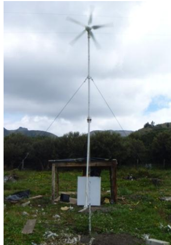
Figura 3.28 REGULACIÓN DEL CABLE TENSOR EN LOS ANCLAJES CORRESPONDIENTES.
