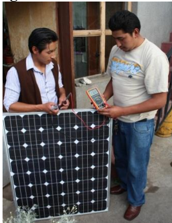
Figura 3.26 PRUEBA DE EQUIPOS.
