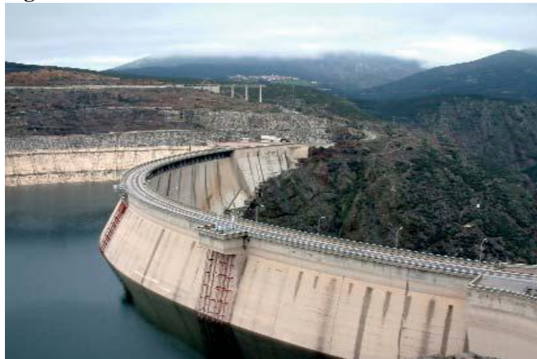
Figura 1.2 CONSTRUCCIÓN DE UN EMBALSE.
