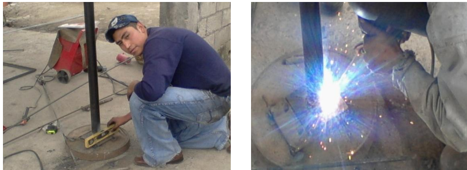
Figura 3.25 CONSTRUCCIÓN DE LAS PLACAS.
