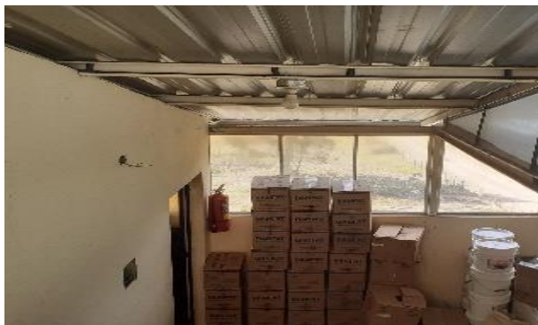
Aberturas en el techo
