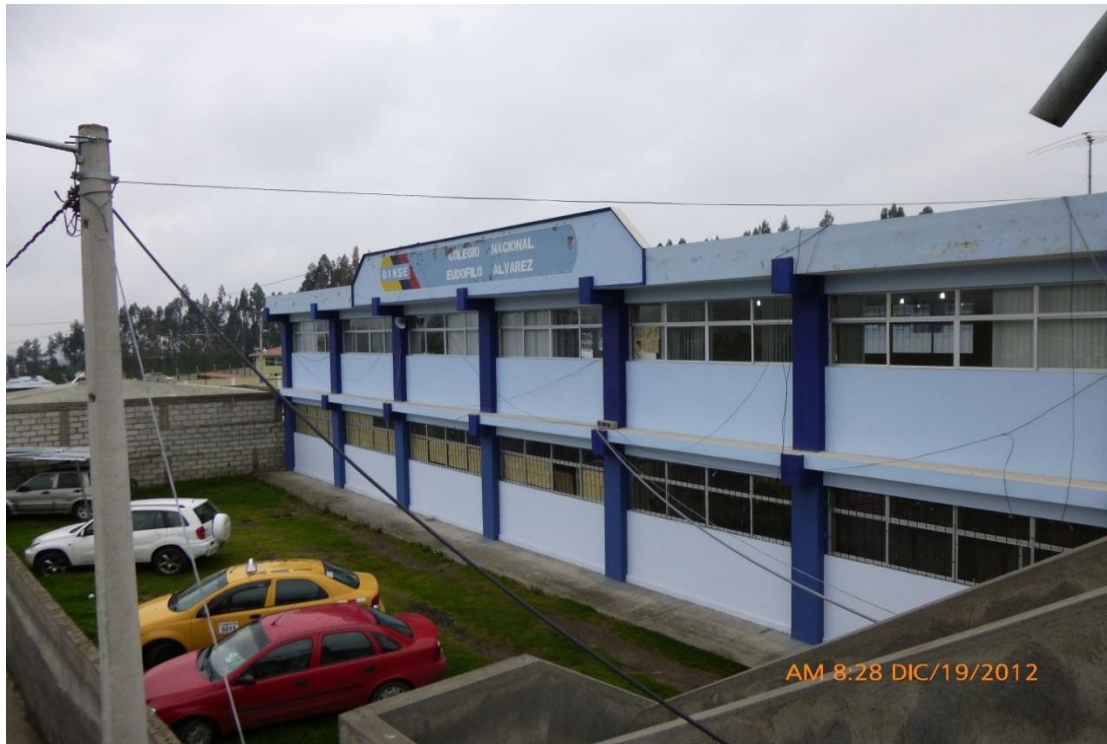
INFRAESTRUCTURA COLEGIO NACIONAL "EUDÓFILO ÁLVAREZ"
