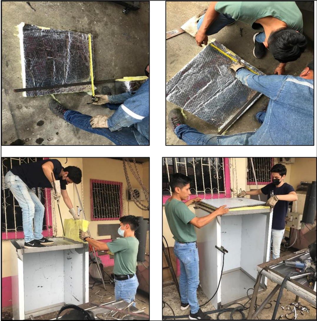
Figura 36. Corte y Colocación de aislante térmico (LANA AW).
