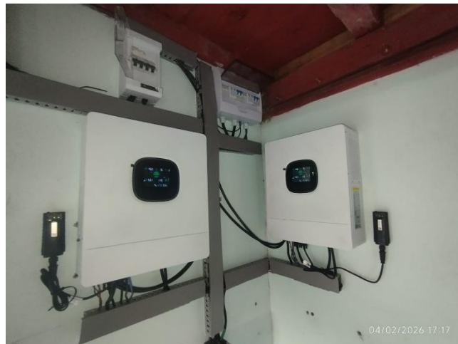
Figura 28 Intercomunicadores de inversores.
