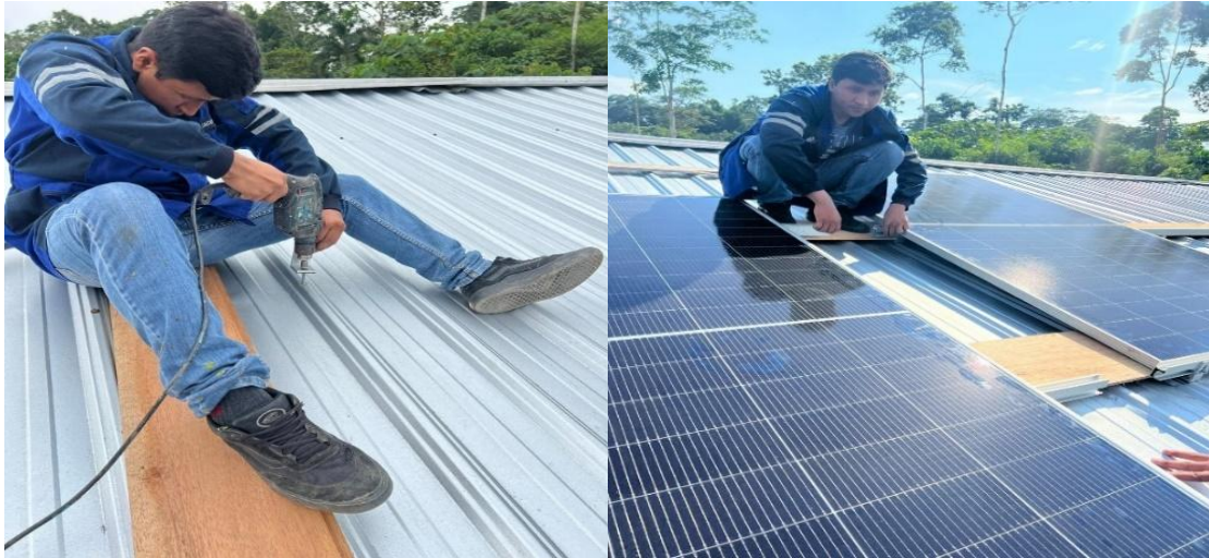
Figura 21 Instalación de soportes, rieles y paneles.
