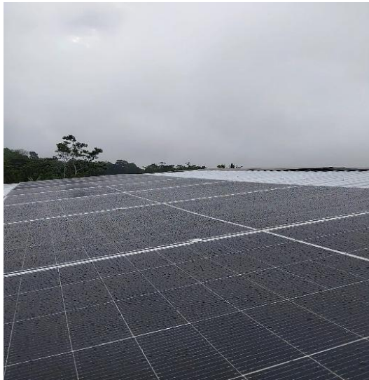
Figuras 22 Paneles acoplados y comprobados.
