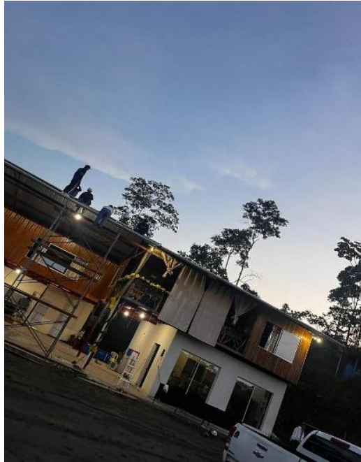
Figuras 27 Vivienda energizada.
