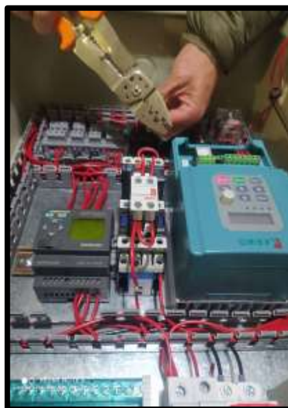
Figura 4.25 Conexiones del tablero de control.
