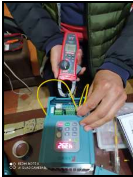
Figura 4.26 Verificación de conexiones.
