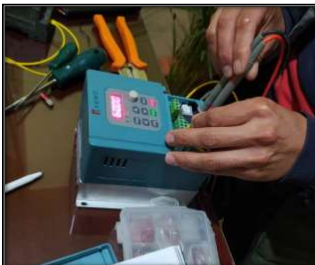
Figura 4.18 Programación del variador.
