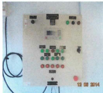
FIGURA 3.35: INSTALACIÓN DEL TABLERO
