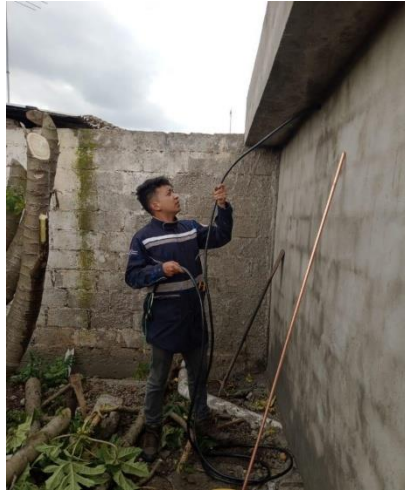
Figura 8.46. Colocación y conexión cable superflex 3x8.
