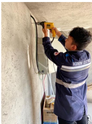
Figura 8.44. Colocación canaletas ranuradas 40x40cm.
