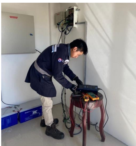
Figura 5.31. Instalación del analizador de red Pure BB.
