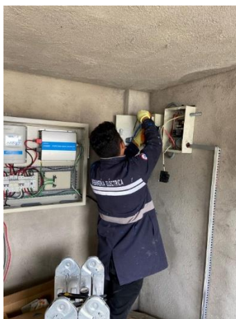
Figura 8.42. Colocación componentes bypass.
