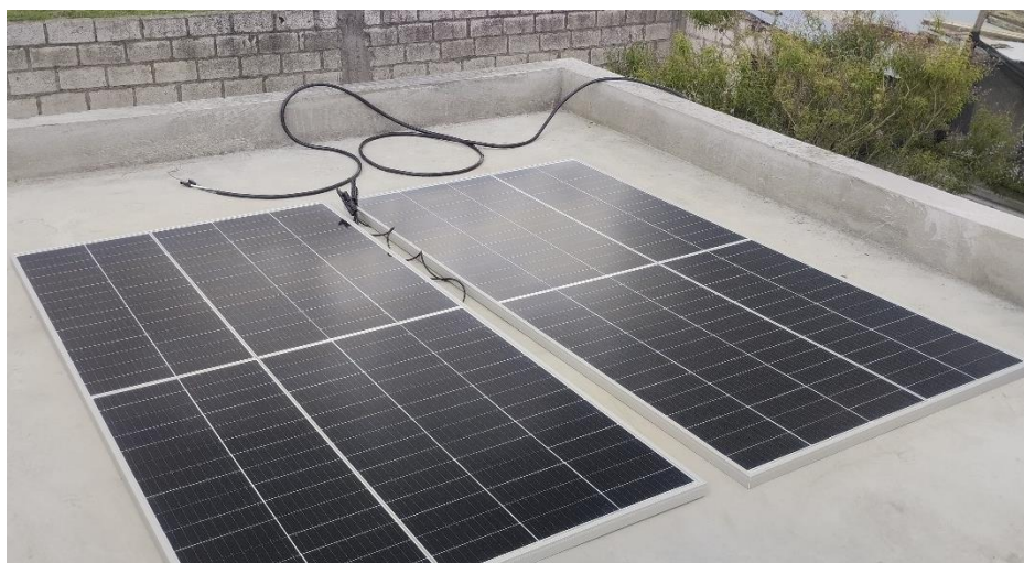
Figura 4.15. Instalación de los paneles fotovoltaicos en el área respectiva.
