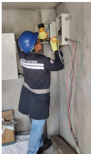
Figura 8.41. Colocación riel, contactores de la caja bypass.
