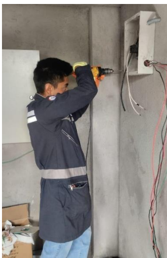
Figura 5.40. Colocación caja bypass.
