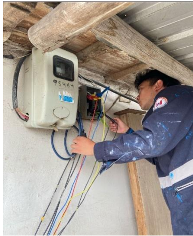
Figura 8.37. Colocación de los lagartos y ondas de corriente para la medición y análisis inicial del predio.
