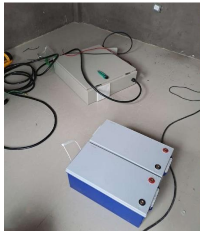
Figura 8.38. Ensamblaje y conexión de los equipos eléctricos.
