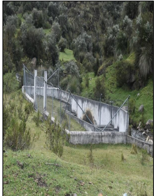
Construcción de obras para abastecimiento de agua
