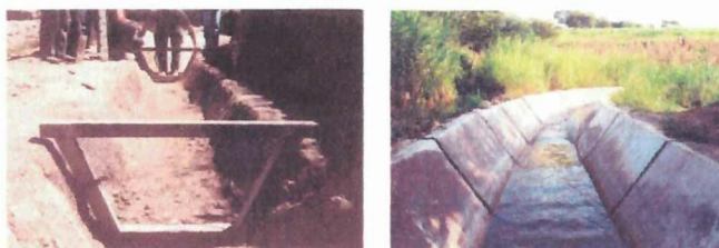
Figura 2. 7 CERCHA Y CANAL DE CONCRETO REVESTIDO POR EL MÉTODO DE LAS CERCHAS
