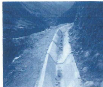
Figura 1. 24 CANAL DE DERIVACIÓN
