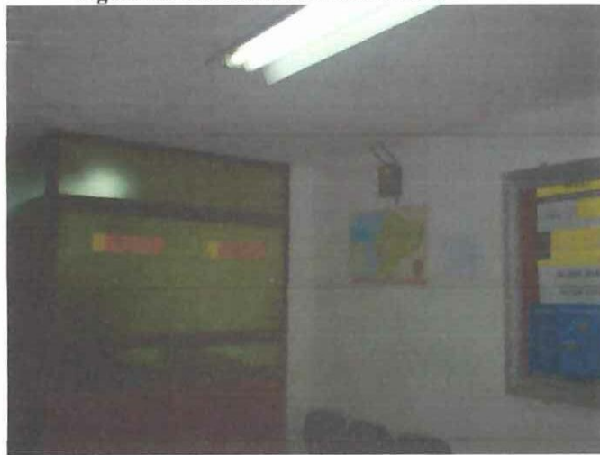
Figura 30: Ubicación de los Access Point.
