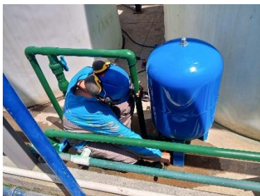
Figura CC.1 Corrección de fugas en las tuberías
