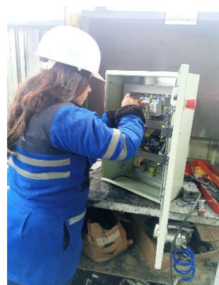
Figura X.1 Realizar ajustes en las conexiones eléctricas del tablero
