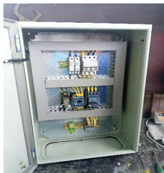
Figura V.1 Instalar y distribuir los componentes eléctricos dentro del gabinete
