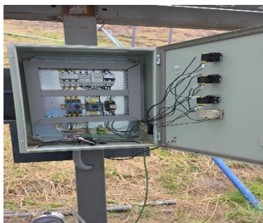
Figura AA.1 Instalación del tablero de control
