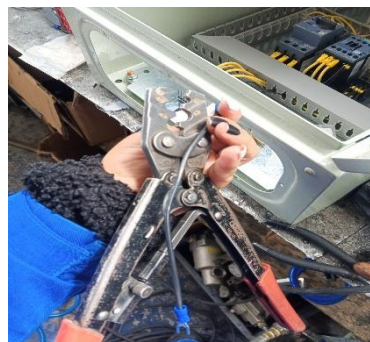
Figura T.1 Crimpado de terminales eléctricos en conductores
