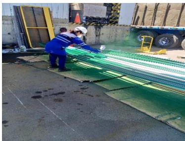
Figura M.1 Pintado de las tuberías
