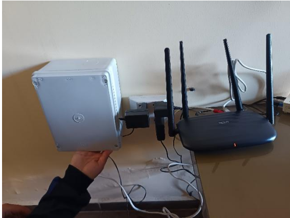
Instalación del equipo receptor en el router del usuario residencial
