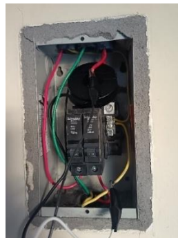
Figura 5.8 Conexión del registrador de parámetros eléctrico al usuario residencial
