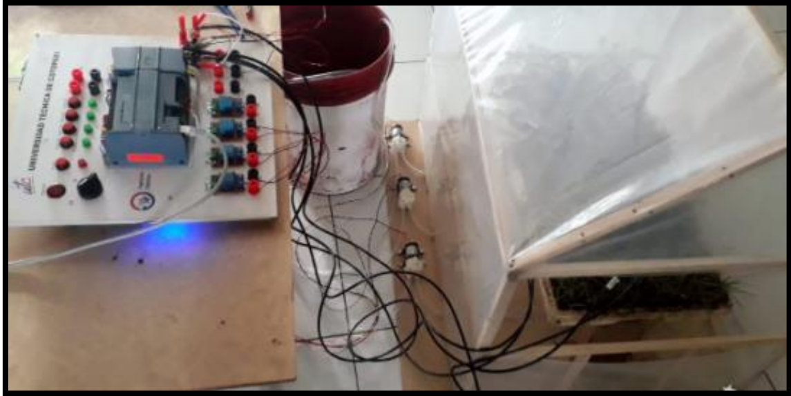
Anexo 1.13 Instalacion final de los elementos para la prueba de funcionamiento.
