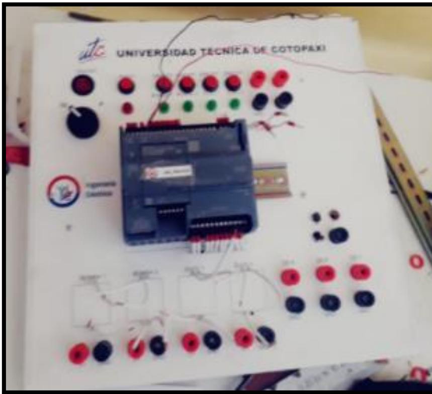
Anexo 1.5 Armado del tablero de control manual.
