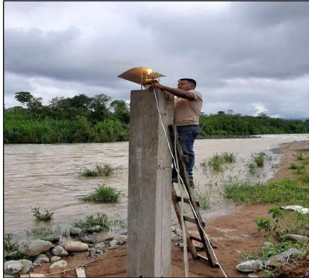
Figura 16: Instalación del sensor en la estructura de concreto
