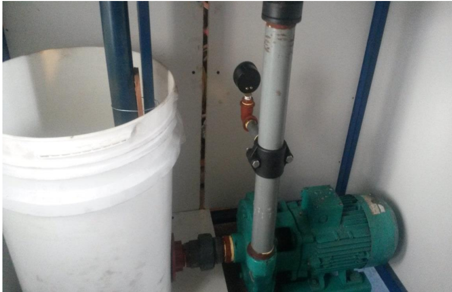
FOTOGRAFÍA 1.5. Instalación de las tuberías
