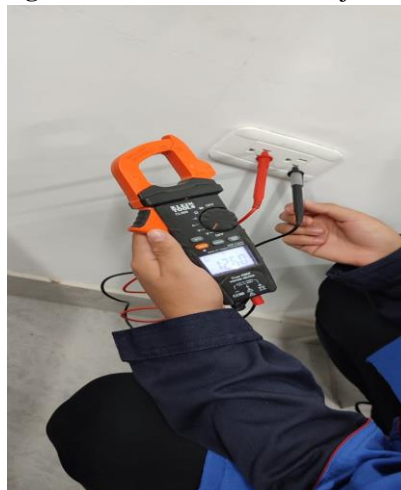
Figura 39. Mediciones de voltajes en tomacorriente aula 13
