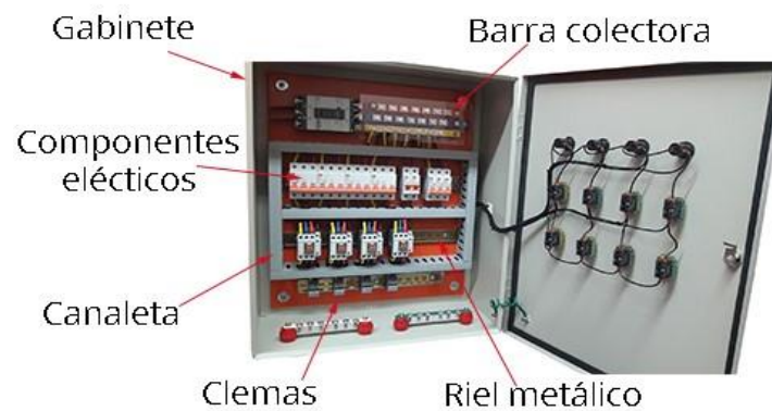
Figura 14. Componentes principales de un tablero eléctrico
