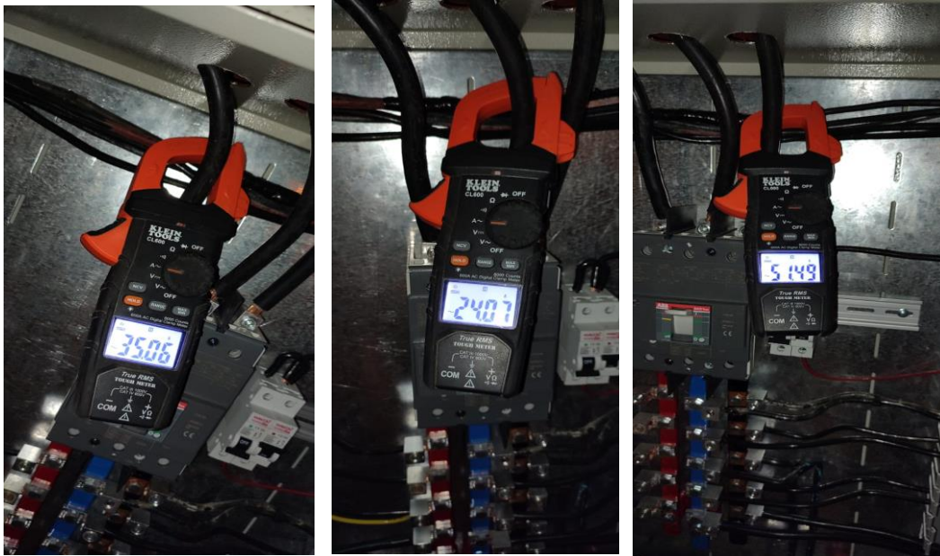
Figura 38. Mediciones de corrientes en cada una de las fases a) Fase 1 b) Fase 2 c) Fase 3
