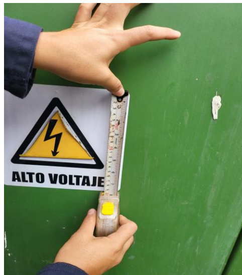
Figura 30. Proceso de reacondicionamiento de transformador
