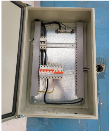
Figura 37. Implementación de tablero de distribución secundario laboratorios
