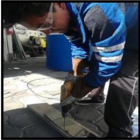
Figura N7. Perforación de las planchas de acero inoxidable.
