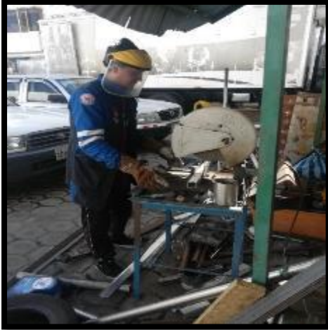
Figura N1. Medición y corte de la tubería cuadrada de acero inoxidable.
