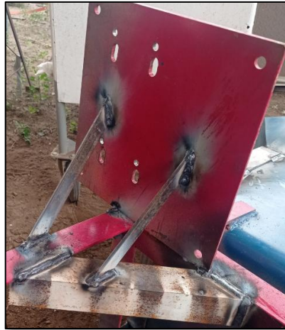
Figura 5.9: Soldadura de refuerzos estructurales en el soporte del conjunto.
