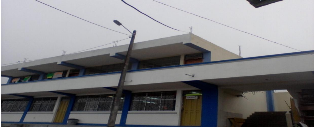
FIGURA N°1 AULAS DE LA ESCUELA
