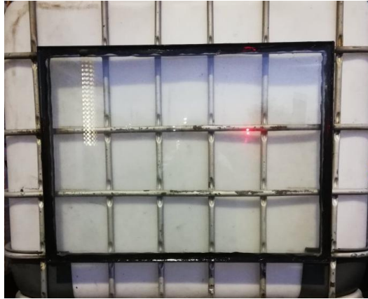
Ilustración 25 Colocación del doble vidrio
