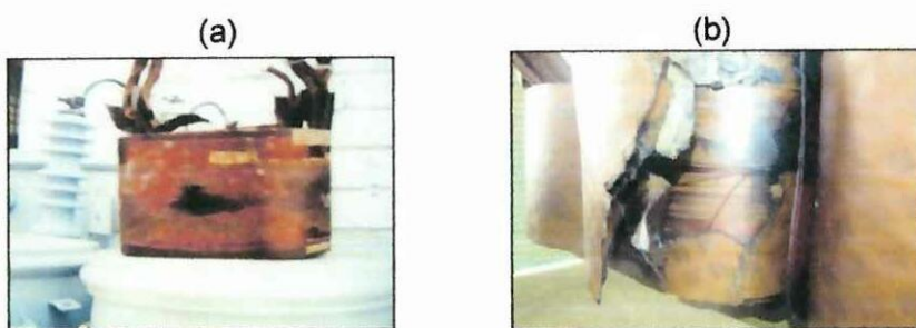
FUENTE: Grupo de investigación de la EEARN S.A., (laboratorio de transformadores)
