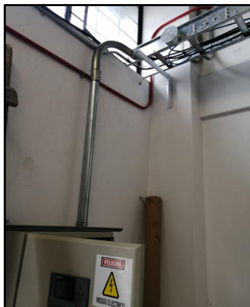
Figura 4.31. Instalación de la tubería galvanizada de 1 ½".
