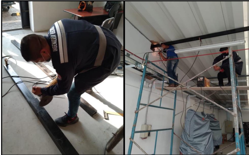
Figura 4.24. Montaje de la estructura metálica.
