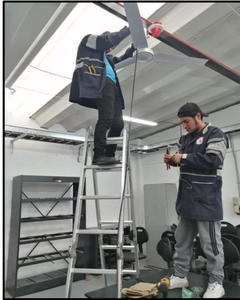
Figura 4.26. Conexión del ventilador.
