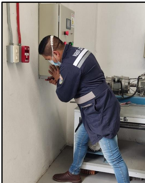
Figura 4.23. Montaje del tablero de control.
