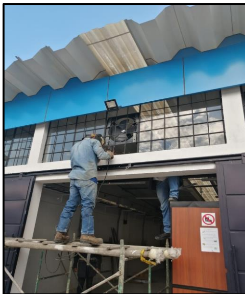
Figura 4.27. Montaje del extractor de aire.
