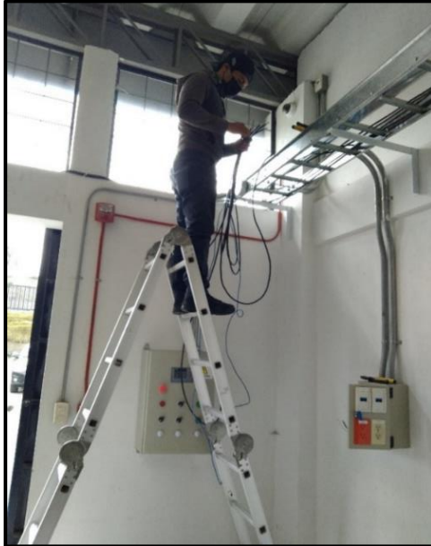
Figura 4.32. Cableado de los conductores por la tubería galvanizada de 1 ½".
