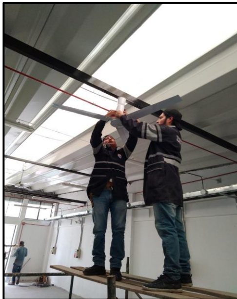
Figura 4.25. Montaje del ventilador sobre la estructura metálica.
