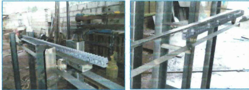
FIGURA 3.28: MONTAJE DE LA CREMALLERA
