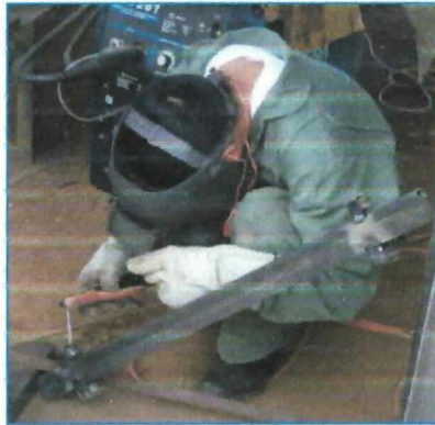
FIGURA 3.26: SOLDADURA DE SISTEMA DE EMPUJE
