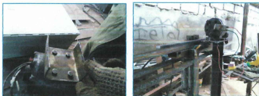
FIGURA 3.32: MONTAJE DEL MOTORREDUCTOR
