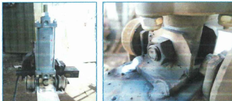
FIGURA 3.29: MONTAJE DE CILINDROS NEUMÁTICOS
