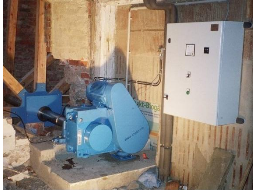
FIGURA N° 23 TABLERO DE CONTROL EN RUEDA HIDRAULICA
