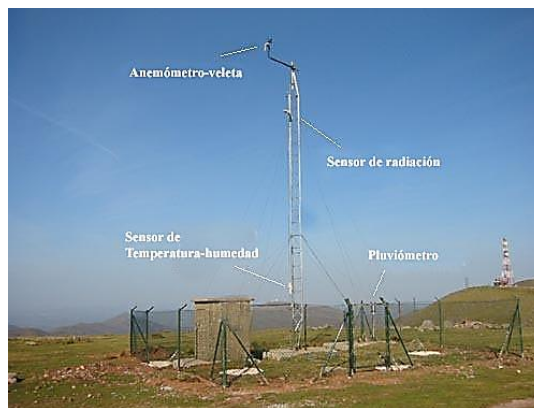
Figura 3.4. Estación meteorológica automática
