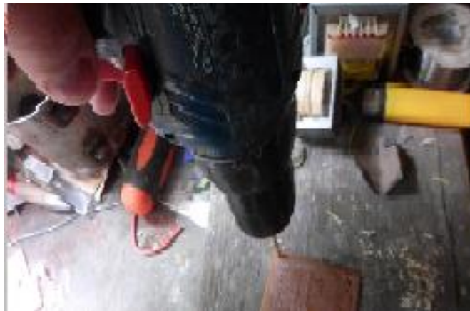
Figura 9.6. Perforación y soldadura de la placa
