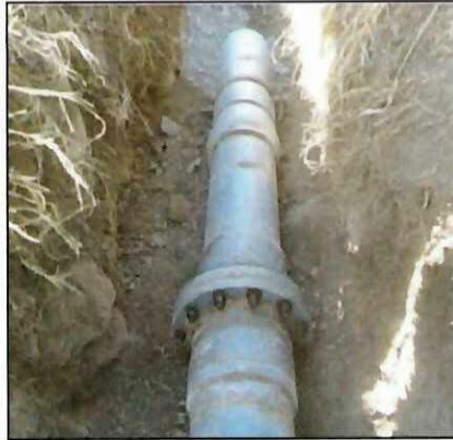
Figura 90 Unión de las Tuberías
