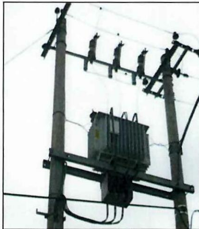
Figura 60 Transformador Trifásico Elevador
