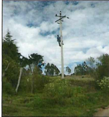
Figura 134 Retiro de Herrajes Obsoletos
