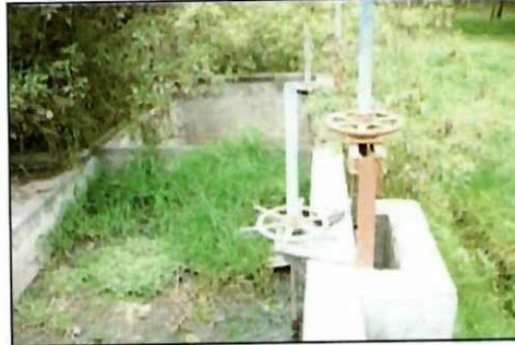
Figura 41 Tanques Llenos de Tierra
