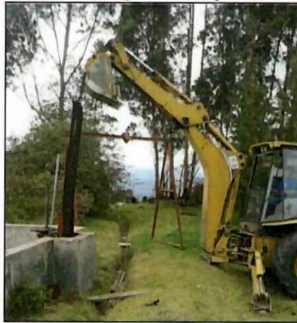
Figura 77 Desmontaje de Compuerta de Volante
