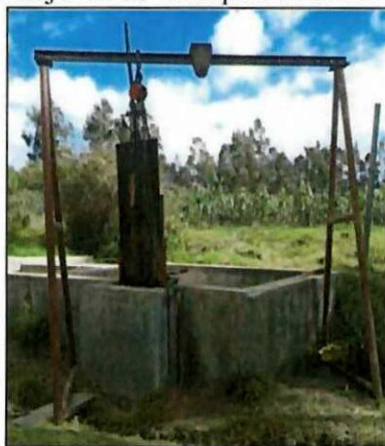
Figura 79 Montaje de la Compuerta de los Desarenadores
