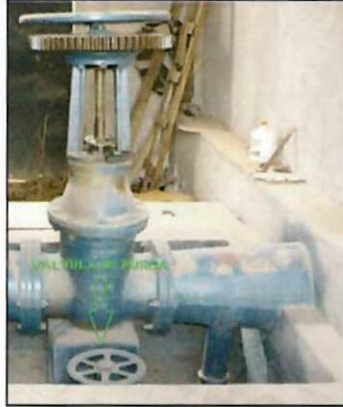
Figura 59 Válvula de Desfogue o Bypass
