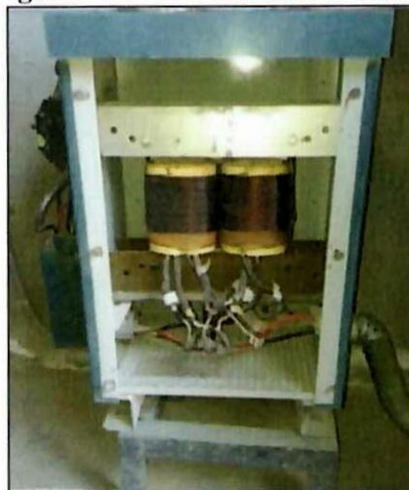
Figura 50 Transformador Auxiliar
