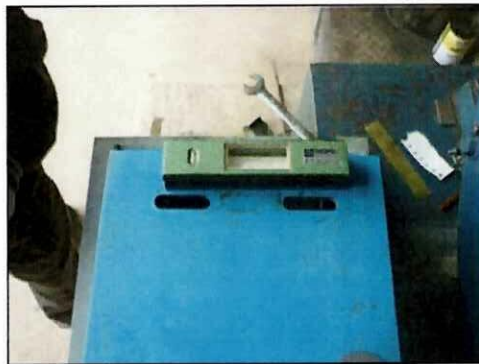
Figura 119 Nivelación de la Base de excitatriz, con el Nivel de Ejes.
