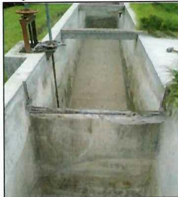
Figura 74 Limpieza de los Tanques Desarenadores
