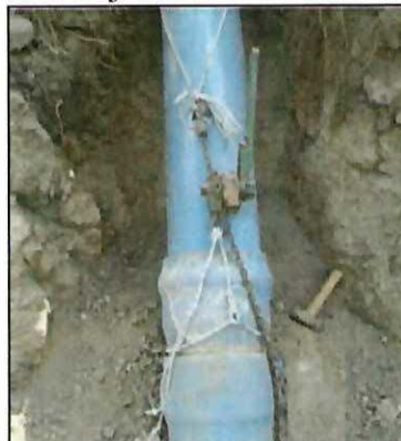
Figura 87 Montaje del Nuevo Codo de la Tubería
