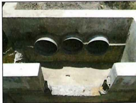
Figura 70 Mantenimiento en la Bocatoma o Captación
