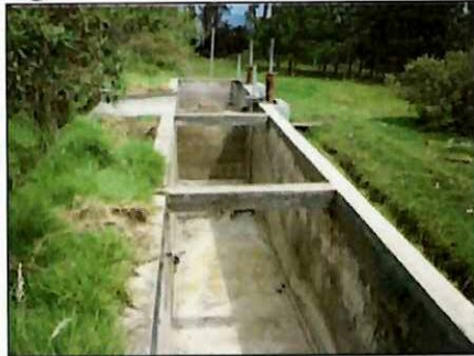
Figura 73 Tanques Desarenadores
