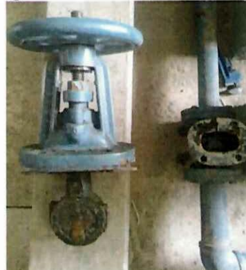
Figura 128 Válvula de Purga
