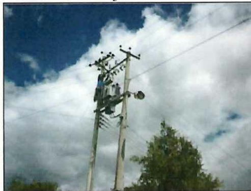
Figura 133 Desmontaje de la Luminaria Obsoleta
