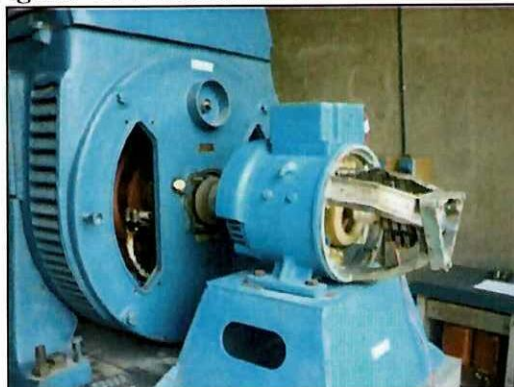
Figura 124 Instalación de Nuevos Resortes
