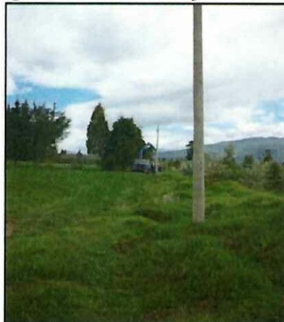
Figura 135 Desmontaje de Postes.
