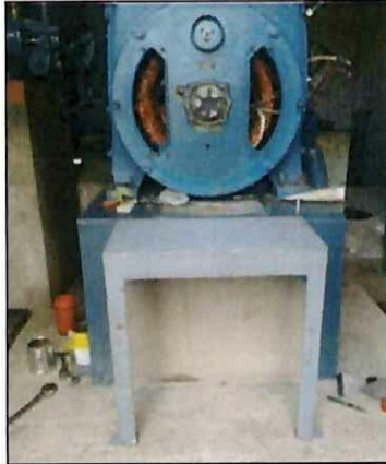
Figura 118 Montaje de la Base para la Excitatriz
