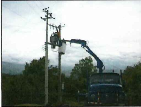
Figura 130 Pruebas de Medición en el Transformador Reductor AEG
