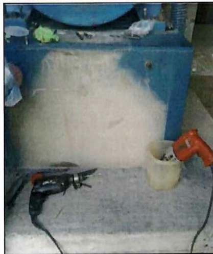
Figura 117 Perforación de Orificios en la Base del Generador
