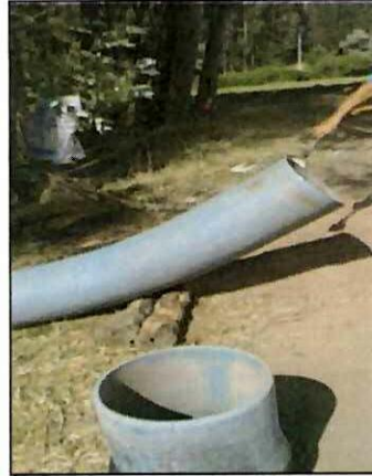
Figura 86 Adecuación del Codo de la Tubería
