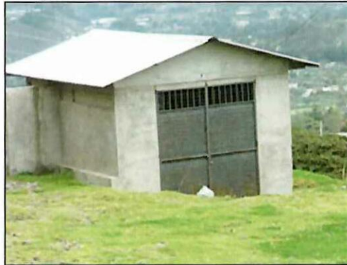
FUENTE: Casa de Maquinas Mini Central AUTORES: CRUZ CÉSAR, AVILÉS MIGUEL
