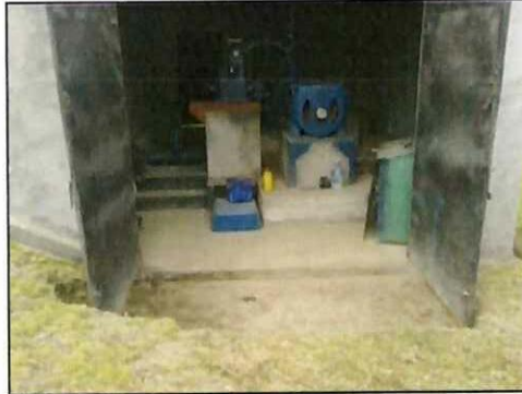
Figura 94 Desbanque de la Entrada de la Casa de Máquinas
