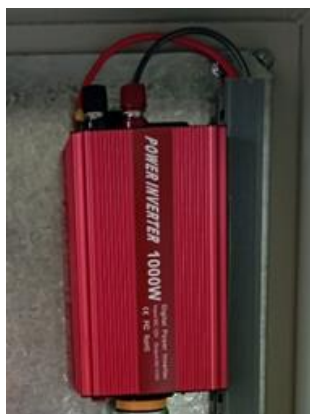
Figura 4.9. Instalación del inversor Cantonape.
