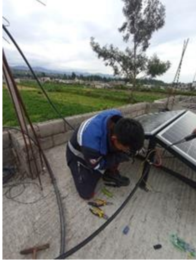
Figura 8.1. Instalación de paneles solares.
