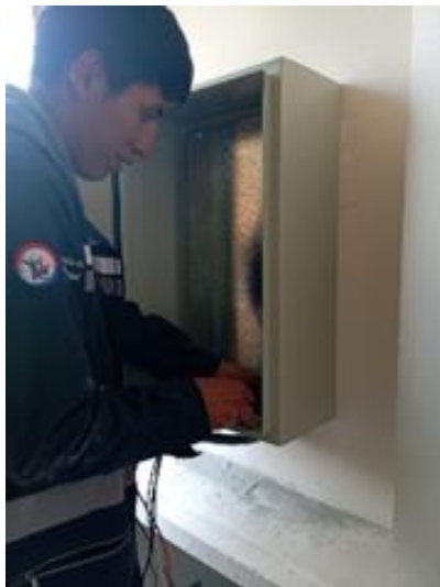
Figura 8.2. Instalación del gabinete metálico.
