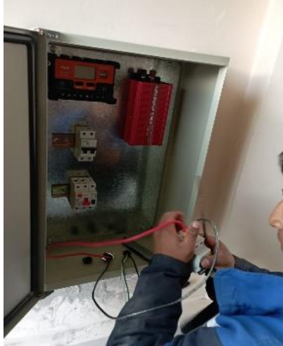
Figura 8.3. Instalación de equipos.
