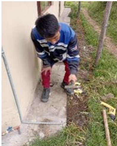
Figura 8.5. Instalación de la varilla copperweld.
