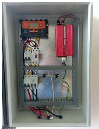
Figura 8.8. Sistema fotovoltaico complementado.
