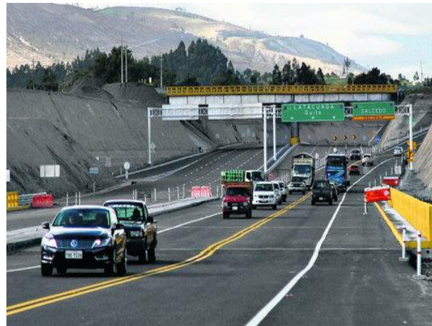
Puente actual Cutuchi 2
