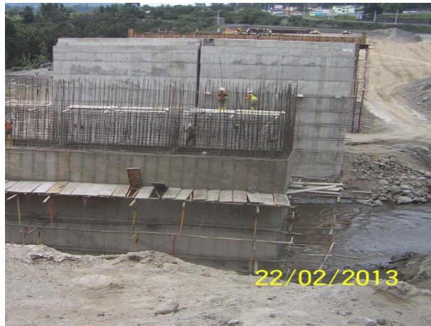
Construcción de la Obra
