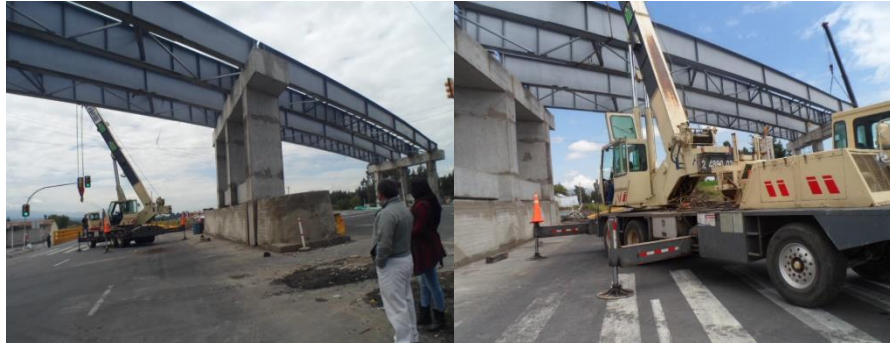
Izaje de vigas
