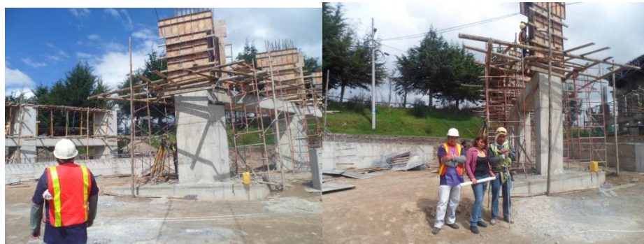
Amarre de Andamios
