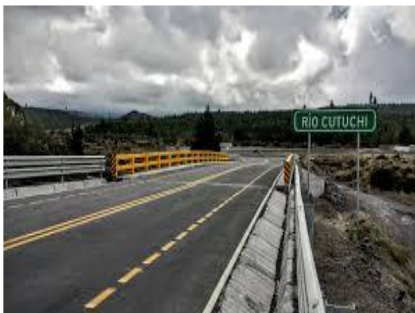
Puente actual Cutuchi 1
