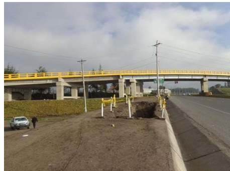
Puente a desnivel Rio Blanco Alto
