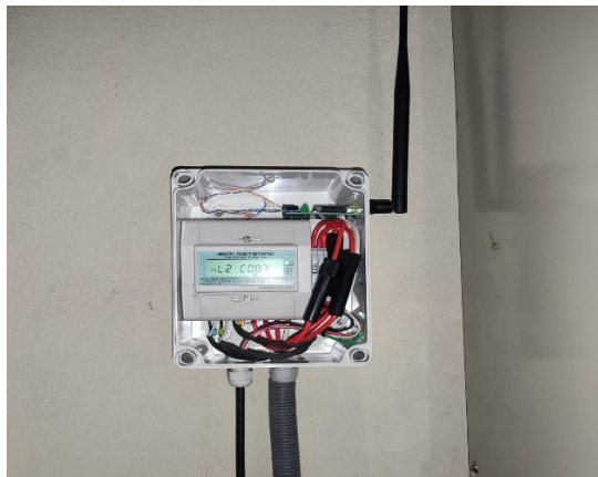
Figura E.5. Instalación del medidor inteligente.
