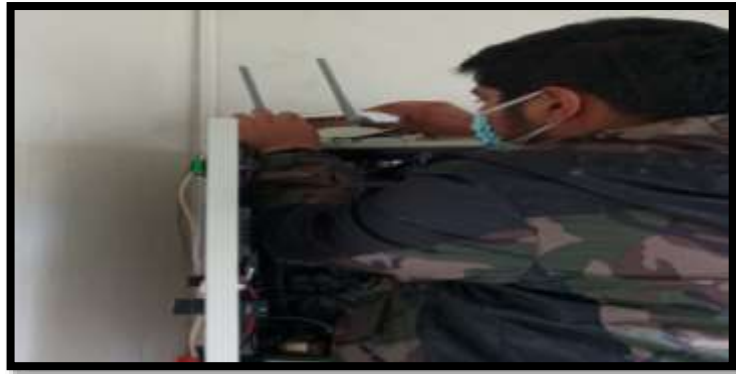
Anexo III. Instalación de router tp-link
