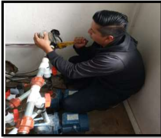
Anexo XII. Conexión del sensor de caudal
