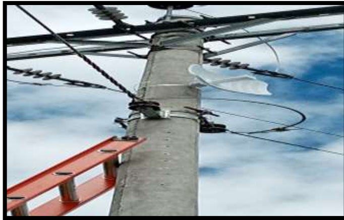
Anexo II. Instalación de antenas ubiquiti punto a punto
