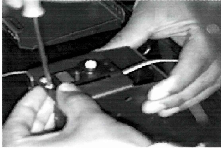
FIGURA No 3.4 : INSTALACIÓN DEL SERVO DE LA INCLINACIÓN FUENTE: INVESTIGADOR
