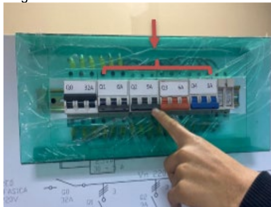
Figura 5. Breakers Q1, Q2, Q3 y Q4 desenergización
