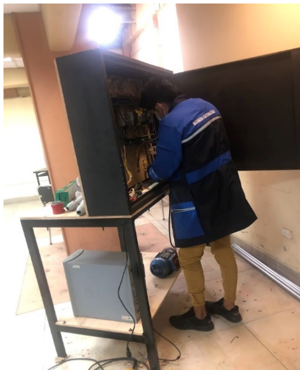
Figura 12. Montaje de componentes y cableado eléctrico.
