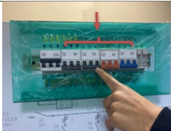
Figura 5. Breakers Q1, Q2, Q3 y Q4 desenergización
