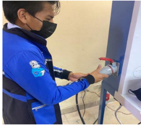
Figura 9. Alimentación trifásica del sistema
