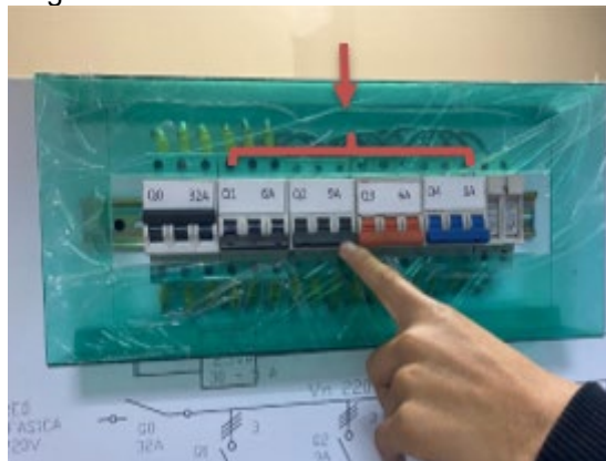
Figura 5. Breakers Q1, Q2, Q3 y Q4 desenergización
