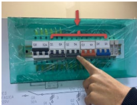
Figura 13. Breakers Q1, Q2, Q3 y Q4 desenergización
