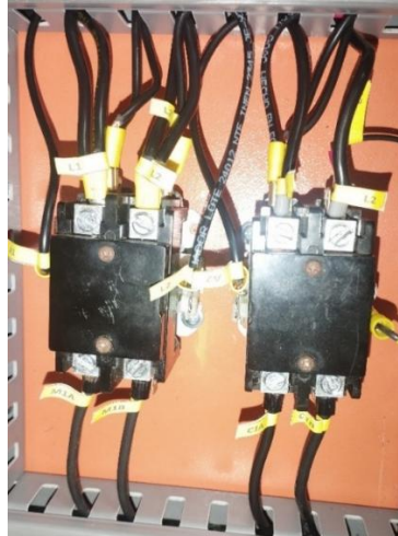
Figura 5.18. Instalación de los contactores eléctricos
