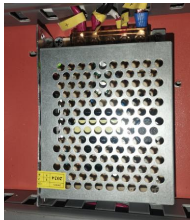
Figura 5.11. Instalación de la fuente de poder
