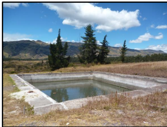
Figura 5. Reservorios de concreto
