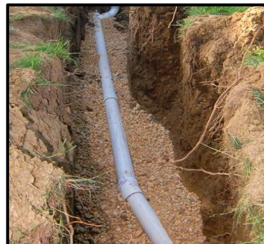
Figura 14. Readecuación de tubería
