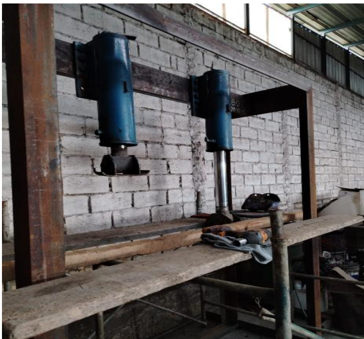
Figura 7: Montaje de pistones hidráulicos
