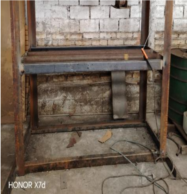
Figura 8: Construcción de la mesa de compactación
