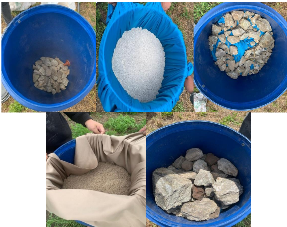
Foto 4. Procedimiento de distribución de medio filtrante
