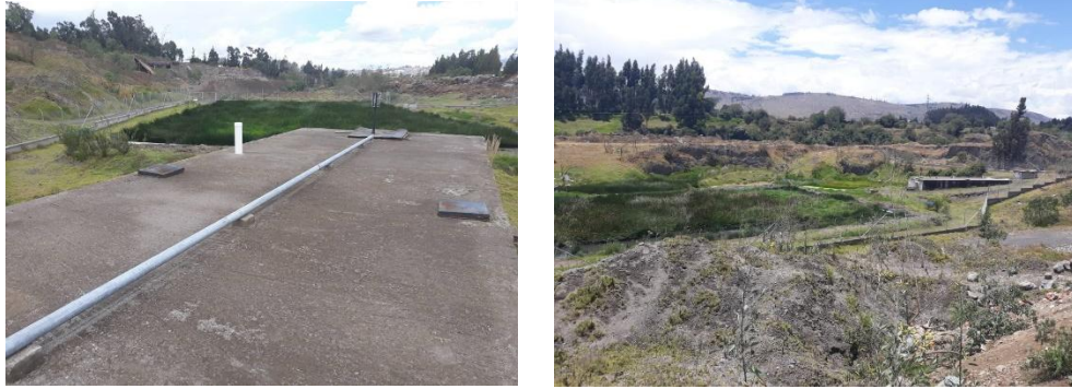
Ilustración 9 PLANTA DE TRATAMIENTO
