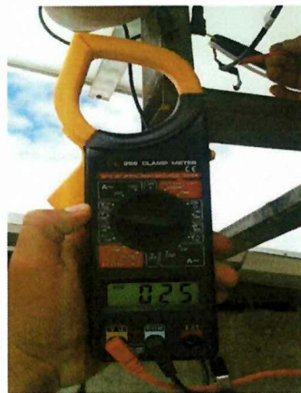
FIGURA 3. 16 Medición de voltaje en los paneles solares
