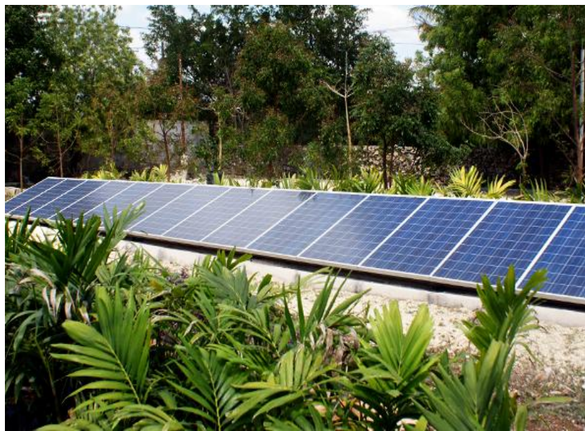
Figura 9. Inclusión de un sistema de riego en plantas mediante un sistema fotovoltaico autónomo.
