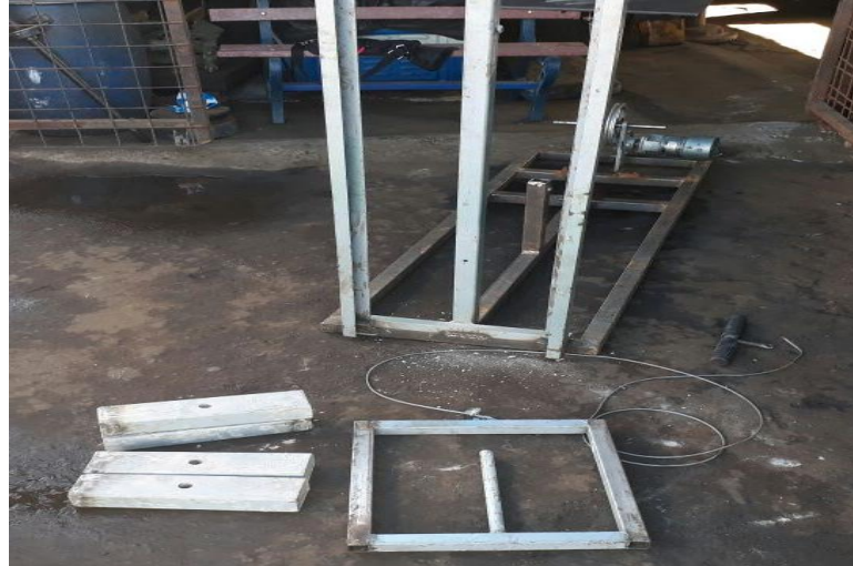
Figura No. 47. Construcción de Pesas, Guía de las pesas
