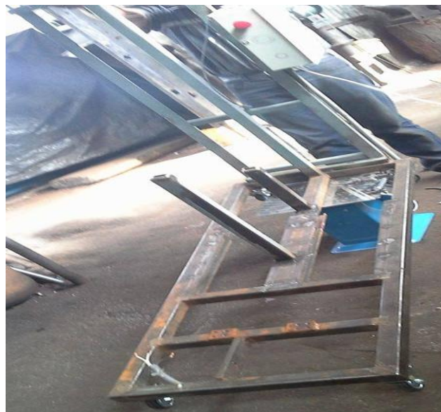
Figura No. 48. Construcción de la Estructura
