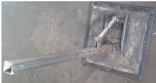
Figura No. 45. Construcción de la Mesa.
